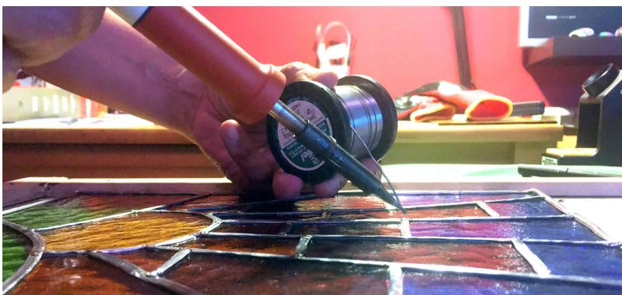
En el caso de usar vidrio transparente, una vez soldadas todas las uniones de los perfiles, se puede proceder a pintar según el plan establecido previamente.
